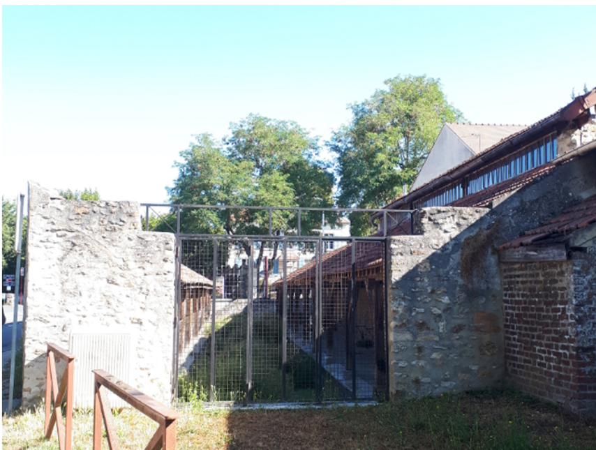
Des grilles et murs bloquent l'accès
