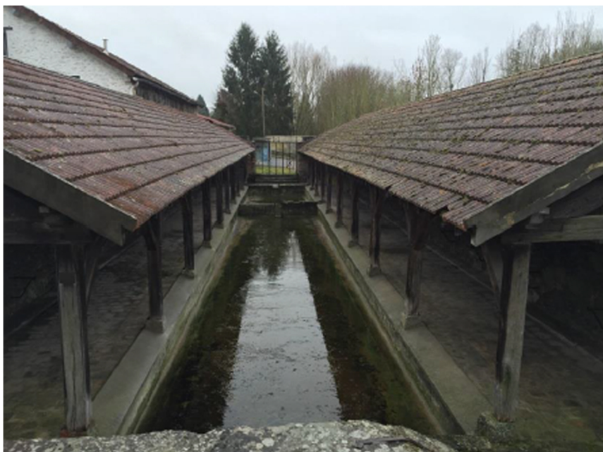
Le lavoir en contre bas de la route
