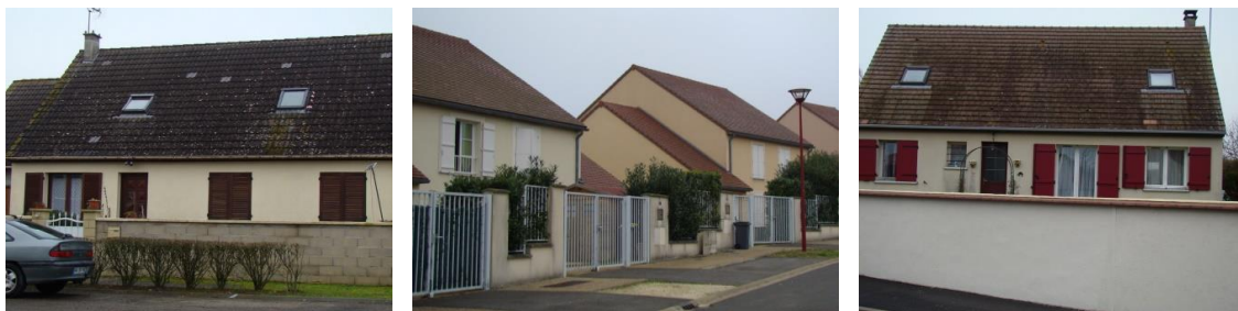
Habitat individuel des années 80-00 implanté sous la forme de lotissements
