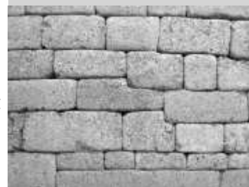
Moellons de pierres
